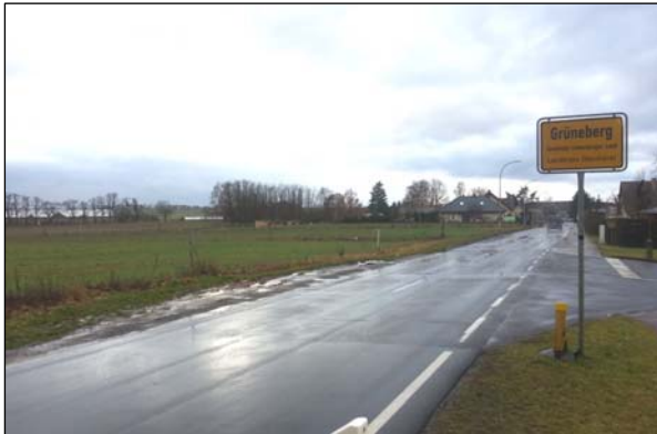
Ergänzungsfäche E 1: Blick von Osten
